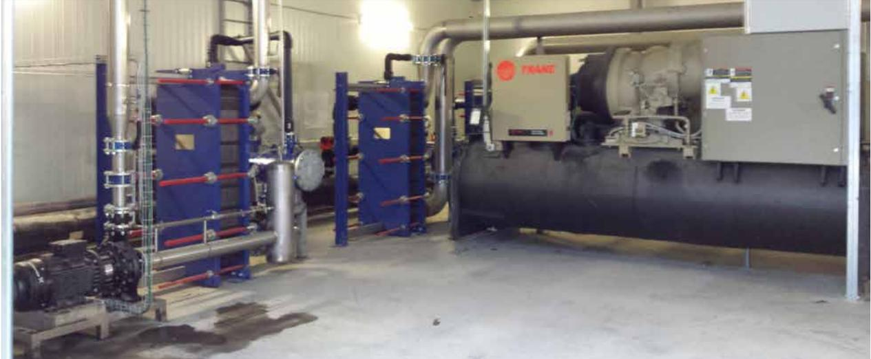
Exclusivo sistema de refrigeración por agua del mar ejecutado en el puerto que permitió prescindir de torres de refrigeración y reducir el consumo energético de los equipos de frío. Una serie de bombas instaladas en el fondo del mar impulsan agua a través de una red de tuberías subterráneas hasta la sala de servicios desde donde es devuelta a una temperatura controlada al fondo del mar.
